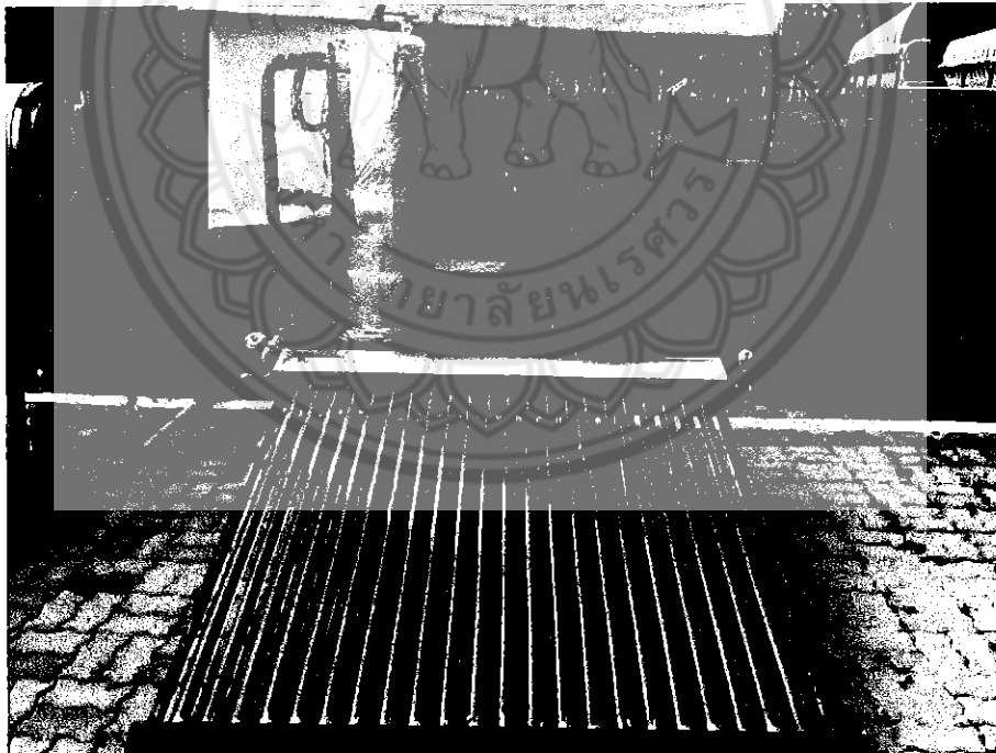
รูปที่ 15 ถังน้ำร้อนที่ติดตั้งร่วมกับตัวเก็บรังสีอาทิตย์แบบสุญญากาศ
