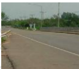
รูปที่ 2.4 ถนนลาดยาง
