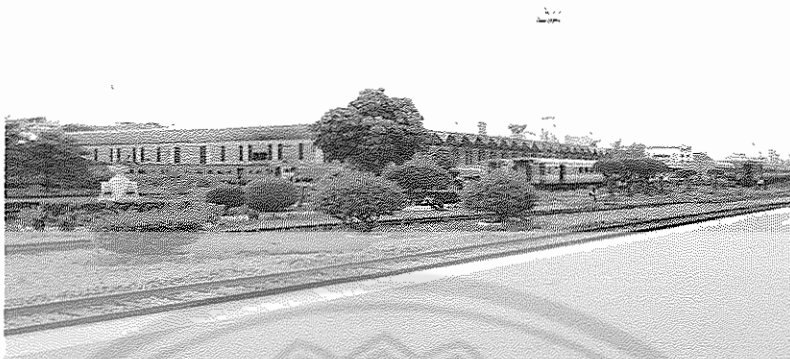
รูปที่ 36 อาคารซ่อมแซมรถไฟ ซึ่งจะย้ายไปไว้ที่สถานีมักกะสัน
