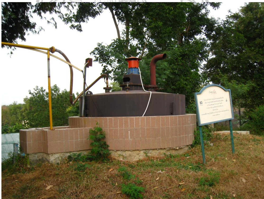
ภาพ 6 แสดงลักษณะบ่อหมักก๊าซชีวภาพจากขยะอินทรีย์แบบถังลอย
