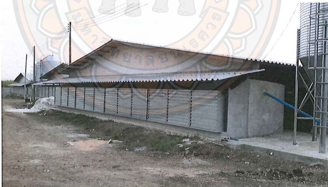
พัดลมดูดอากาศด้านนอกโรงเรือน
