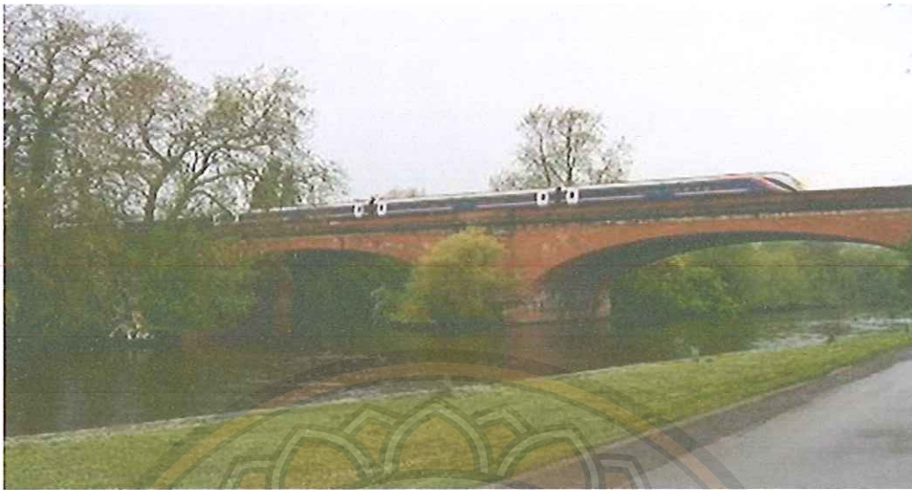
ภาพ 9 สะพานรถไฟต่อเนื่อง 2 ช่วง
