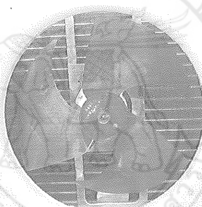
ภาพ 77 แสดงชุดมอเตอร์พัดลมแบบ DC310V ขนาด 30 วัตต์ ที่ใช้สำหรับ Outdoor Unit
