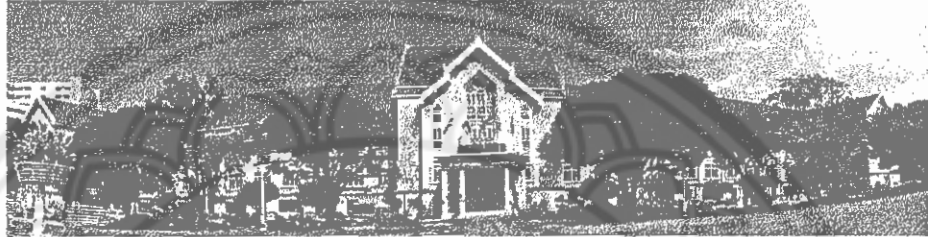
รูปที่ 106 อาคารสำนักงานใหญ่โรงงาน
