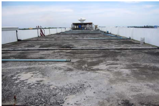
ภาพ 16 พื้นที่สำหรับติดตั้งแผงรับรังสีอาทิตย์ขนาดกว้าง 10 เมตร ยาว 25 เมตร
